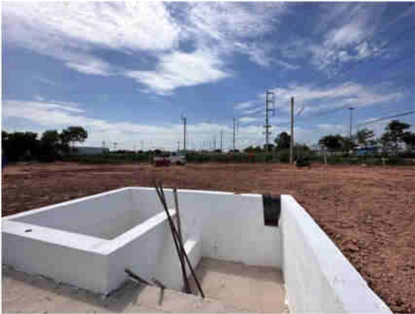
บ่อล้างล้อรถบรรทุกก่อนออกจากพื้นที่ก่อสร้าง (กำลังก่อสร้าง)
